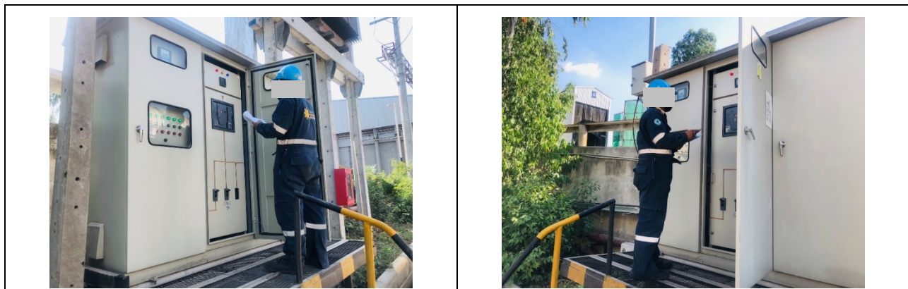
รูปที่ 2.2-43 การตรวจสอบ บำรุงรักษาไฟฟ้าแสงสว่างบริเวณท่าเทียบเรือ
