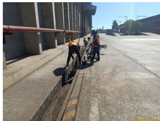
รูปที่ 2.2-21 การทำความสะอาดรางระบายน้ำ และบ่อตกตะกอนภายในโครงการ (ต่อ)
