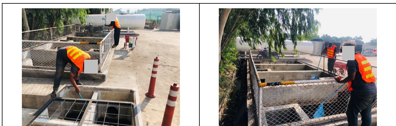
รูปที่ 2.2-22 การทำความสะอาดรางระบายน้ำ และบ่อดักตะกอนภายในโครงการ
