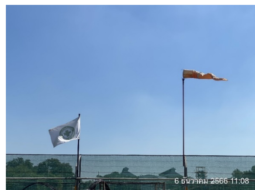
รูปที่ 2.2-16 การติดตั้งถุงลม (Wind Sock) บริเวณหน้าท่าเทียบเรือ เพื่อใช้เป็นเครื่องมือในการสังเกตทิศทางลมและความเร็วลม
