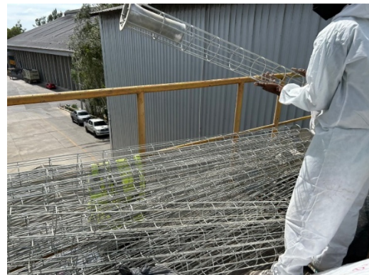
รูปที่ 2.2-13 การบำรุงรักษาในเชิงป้องกัน (Preventive Maintenance Program) ทุก 2,000 ชั่วโมงการทำงาน สำหรับเครื่องจักรหรืออุปกรณ์ที่เกี่ยวข้องกับการควบคุมมลพิษทางอากาศ โดยมีการเปลี่ยนถุงกรองเครื่องดักจับฝุ่น (Bag Filter) เมื่อวันที่ 20 มิถุนายน 2566
